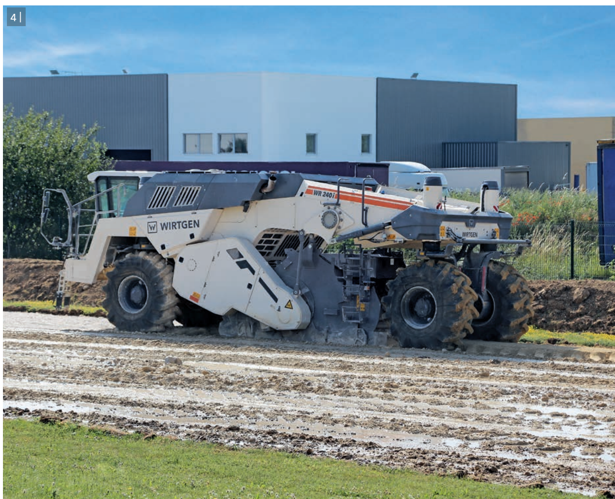
1 - 4 | Os estabilizadores de solo transformam sub-bases com resistência deficiente em solos passíveis de pavimentação e compactação.
